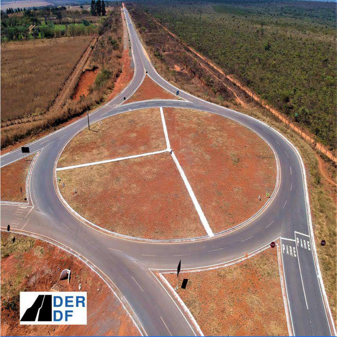
PAVIMENTAÇÃO DF-001 (EPCT) - MORADA DOS PASSÁROS
