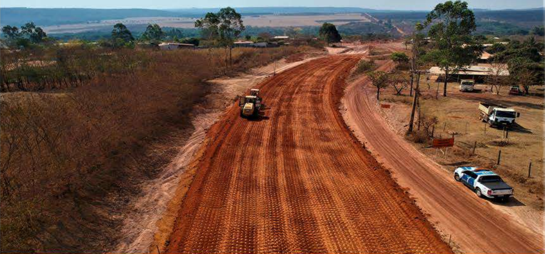
OBRAS DE PAVIMENTAÇÃO DA DF-330
