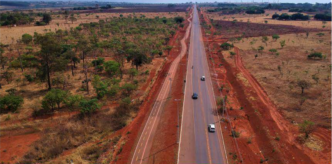
PAVIMENTAÇÃO DA VC-371 E IMPLANTAÇÃO DE CICLOVIA
