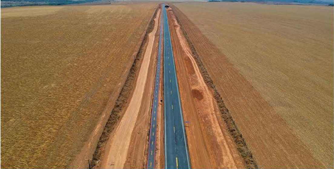
PAVIMENTAÇÃO DA VC-441 E IMPLANTAÇÃO DE CICLOVIA
